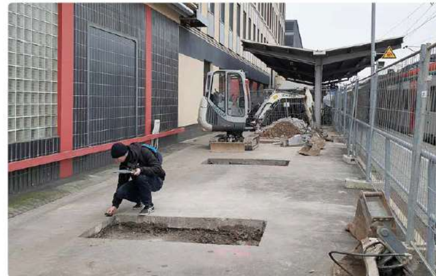
Oben: Neue Doppelstockparker an Gleis 2, unten: Fundamentaushub für die neue Überdachung an Gleis 1
