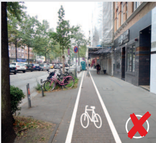
Bild 12 | Gerüst auf Radweg mit schlecht sichtbarer Sicherung
