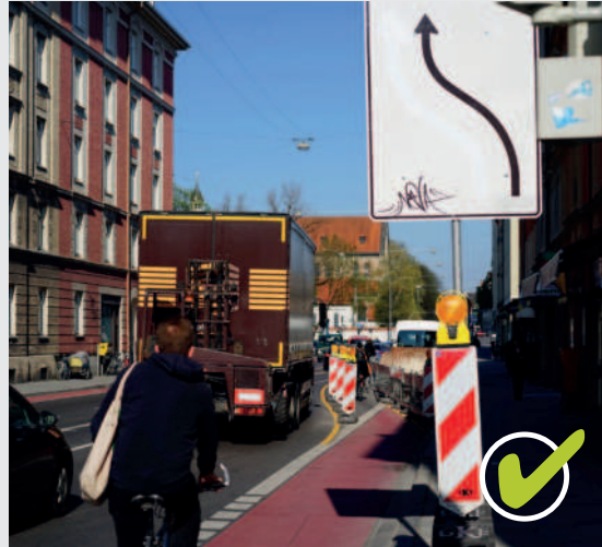
Bild 15 | Arbeitsstelle auf Radfahrstreifen durch Absperrung gesichert
