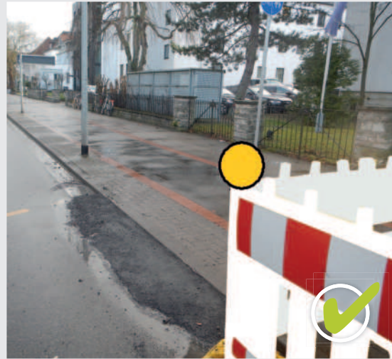
Bild 7 | Anrampung in Form von Asphaltkeil hergestellt
