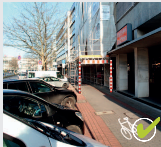
Bild 13 | Gerüst ausreichend gesichert (Anmerkung: Gehweg befindet sich unter den Arkaden)
